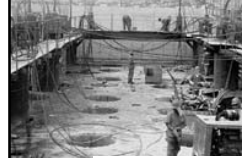
Tubulões a ar comprimido na ponte JK suportam 20 mil toneladas
