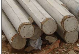
Topo do elemento após a cravação
