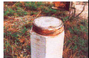
Topo do elemento após a cravação
