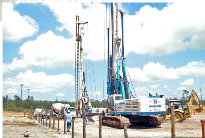
Obra na usina de pelotização - CVRD
